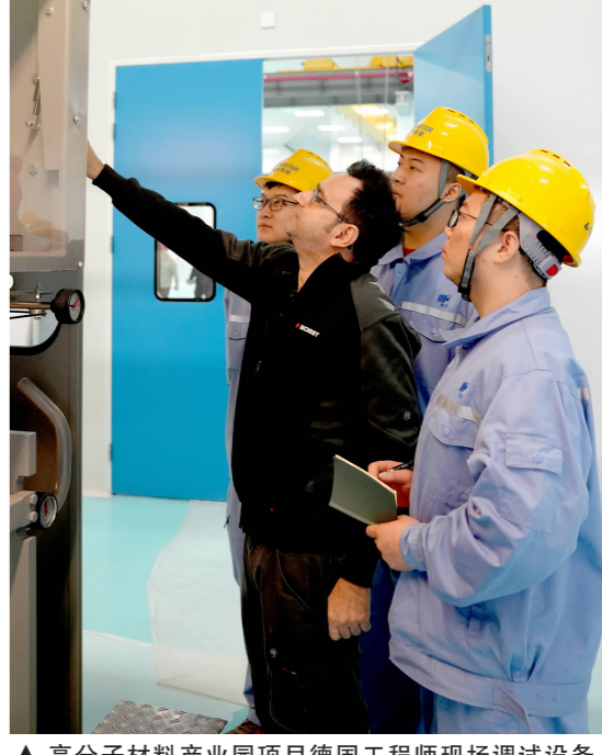
▲高分子材料产业园项目德国工程师现场调试设备
