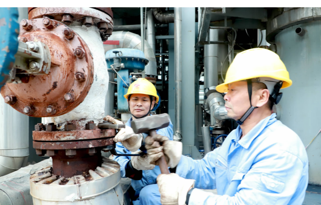
▲科技公司检修人员紧固高压蒸汽进口阀法兰
