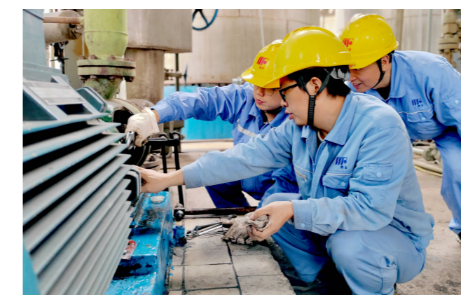
▲化肥分公司检修人员对三期尿素高调水泵油位观察孔实施改造
